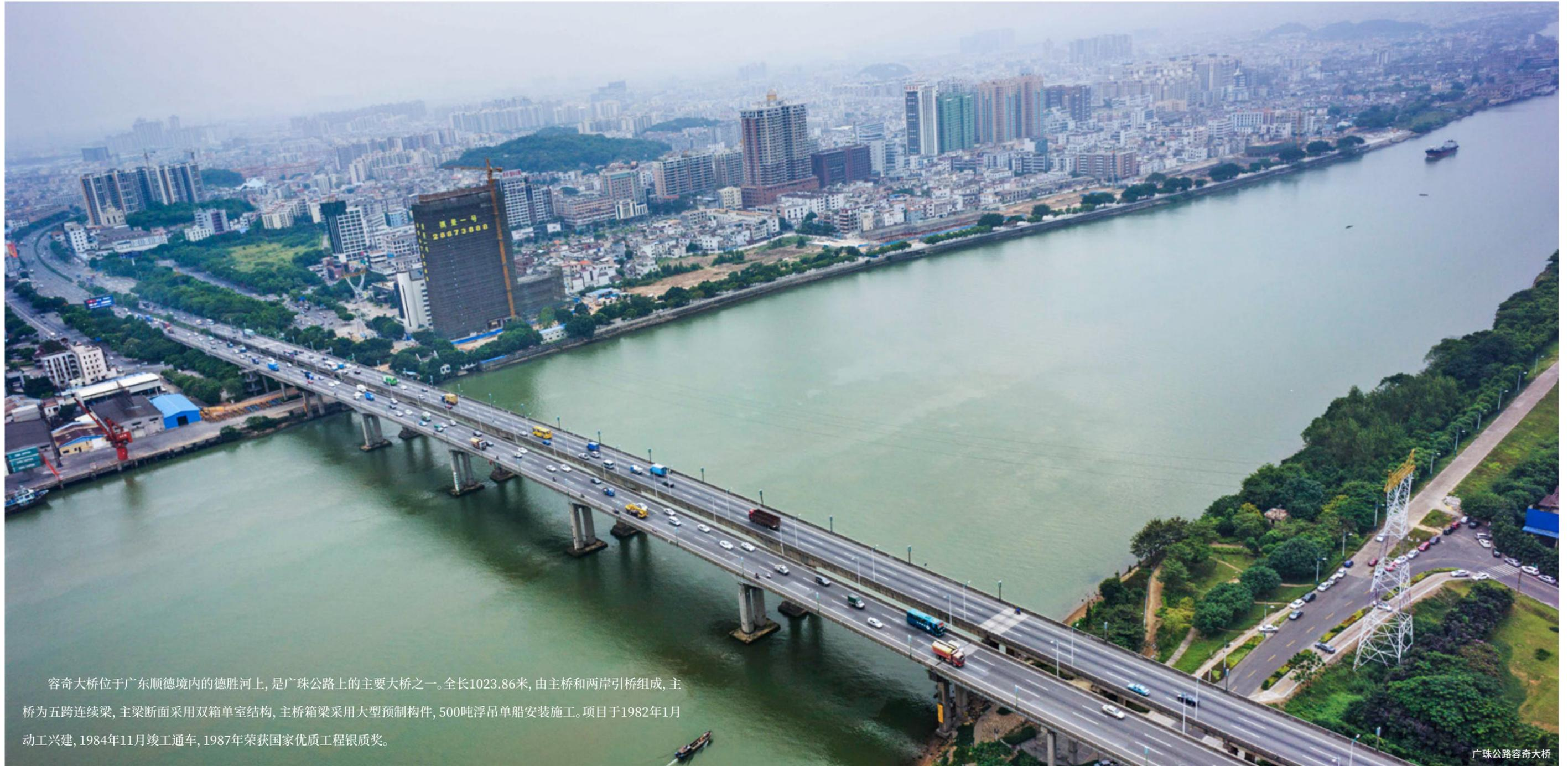
容奇大桥位于广东顺德境内的德胜河上，是广珠公路上的主要大桥之一。全长1023.86米，由主桥和两岸引桥组成，主桥为五跨连续梁，主梁断面采用双箱单室结构，主桥箱梁采用大型预制构件，500吨浮吊单船安装施工。项目于1982年1月动工兴建，1984年11月竣工通车，1987年荣获国家优质工程银质奖。
