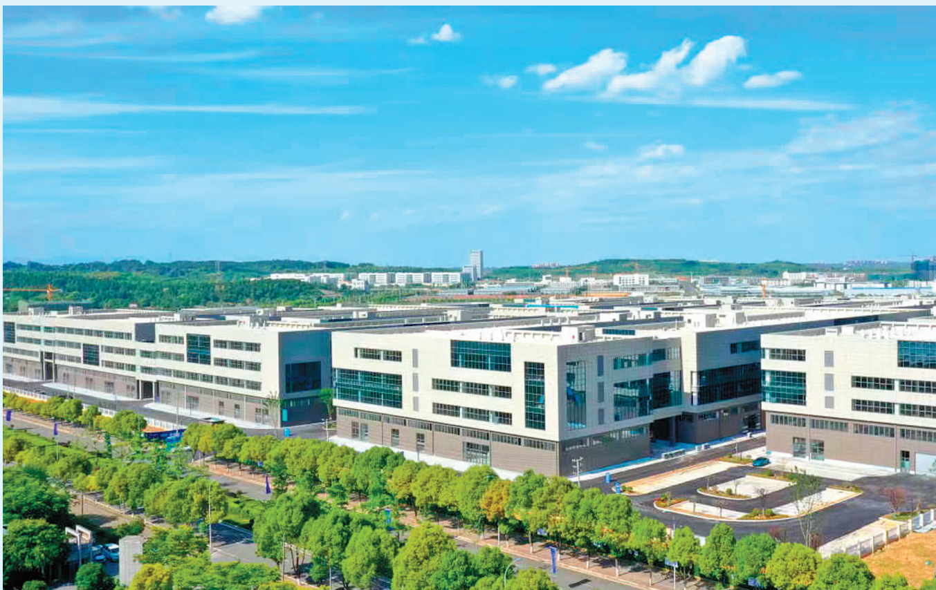
成都建设公司承建的高新发展智能制造产业园(二期)项目 (李婧媚 摄)
